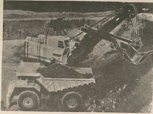
Fig. 2.64. Folosirea scripetelui fix la un excavator.
